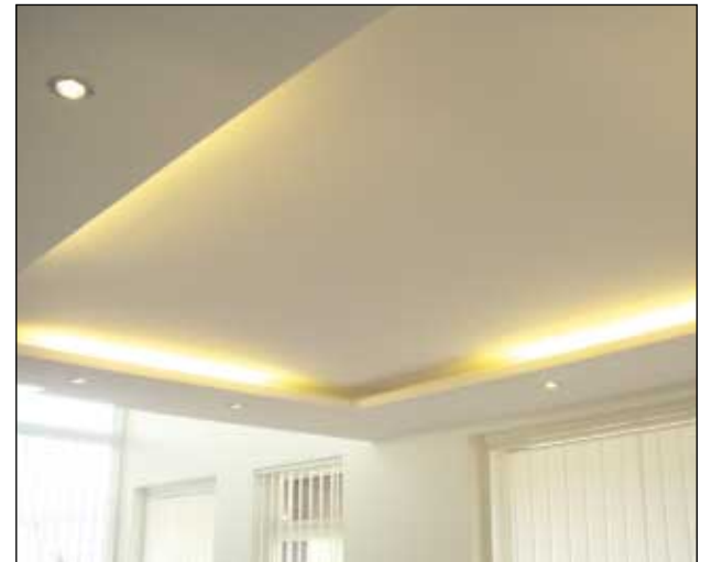
Epäsuora valaistus, katto laskettu reunoilta alas. Halo-geenit ovat turhia häiriövaloja. Valaisimet olisi kannattanut ulottaa koko katon pituudelta ilman tummia välikohtia ja poistaa myös sähköjännitevälkyntä. Muuten hyvä ratkaisu.
