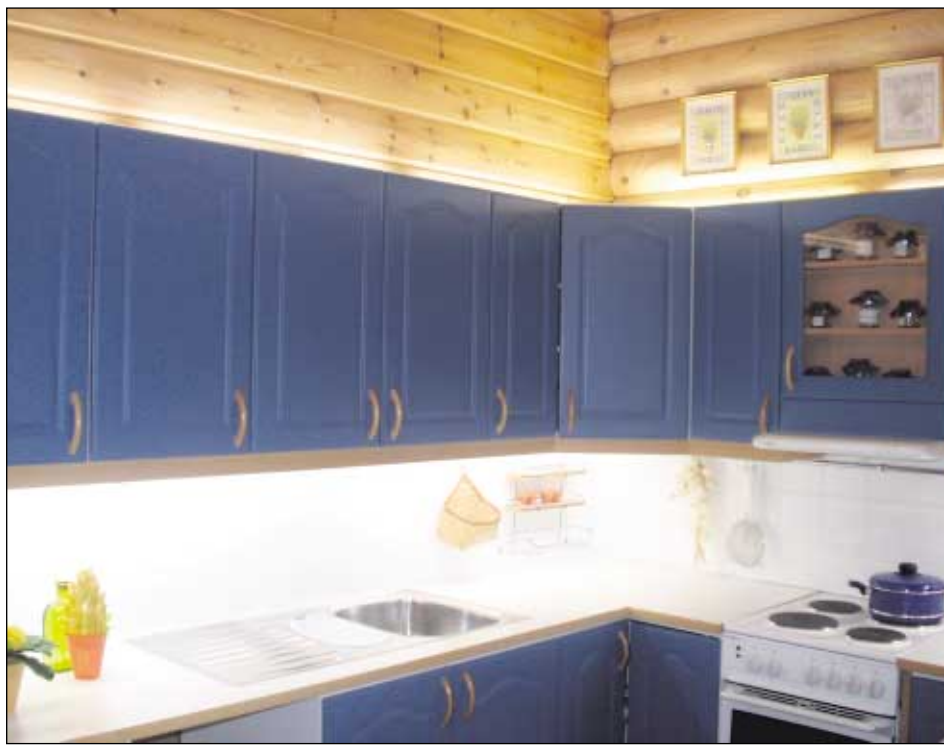
Keittiön oikeaoppinen ja häikäisemätön valaistus. Yläkaapiston etureunan valolistan takana loistevalaisinjonot, kaapiston päällä valaisinjonot (epäsuora valaistus). Kuva Honkarakenteen myyntinäyttelystä Tuusulassa (Eerola-talo).
