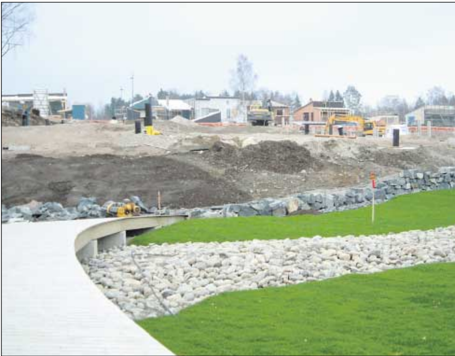
Kivipuro, nurmikenttä ja silta ovat jo valmiina alueen keskellä.
